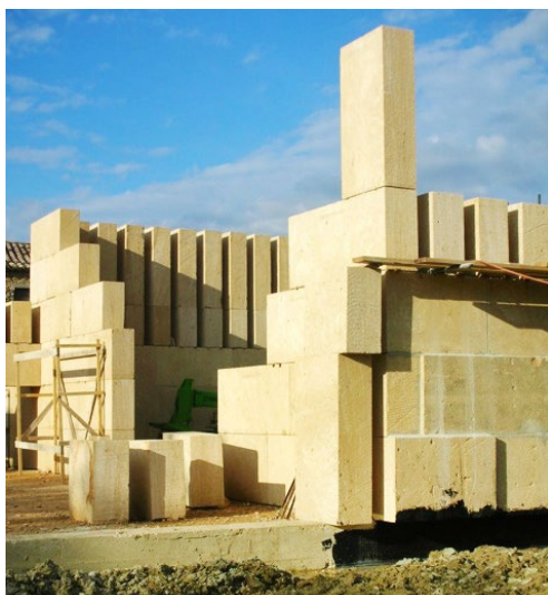
Chantier du monastère de Solan
