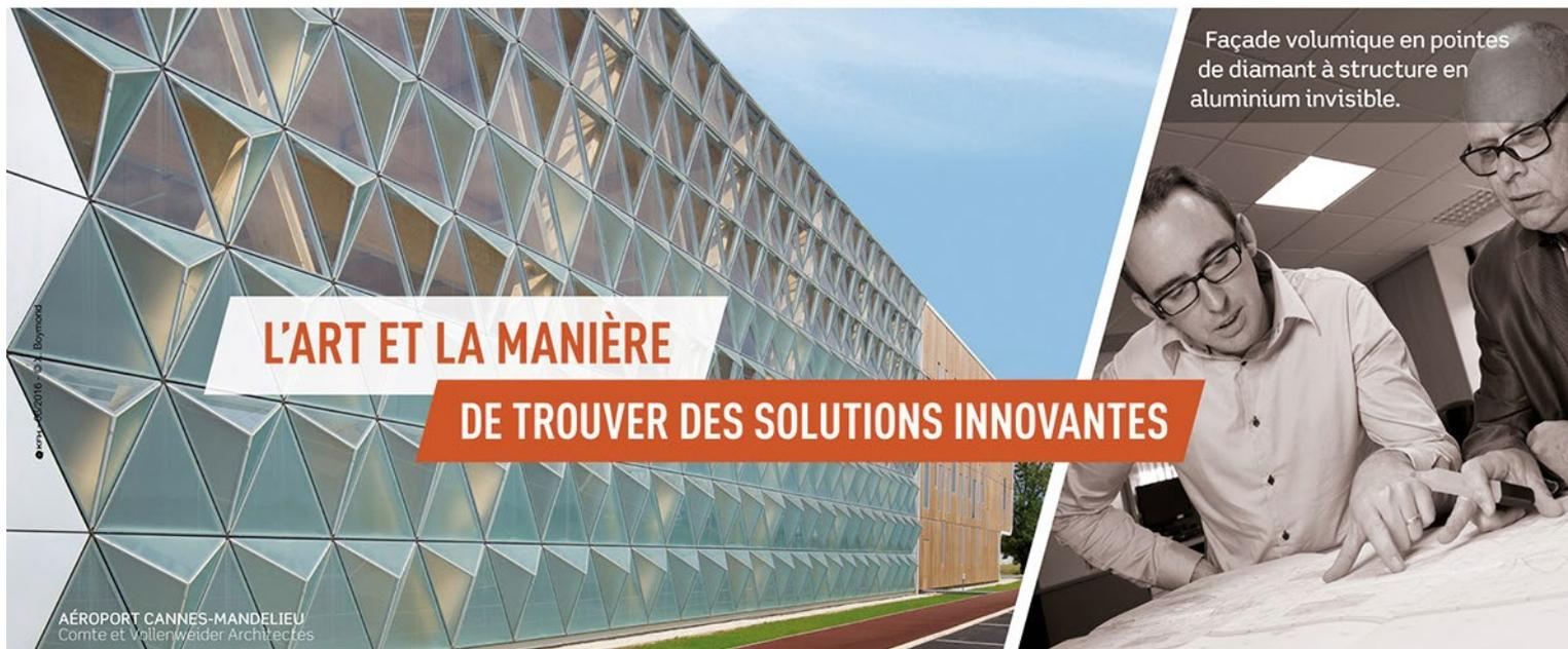
Façade volumique en pointes de diamant à structure en aluminium invisible.
