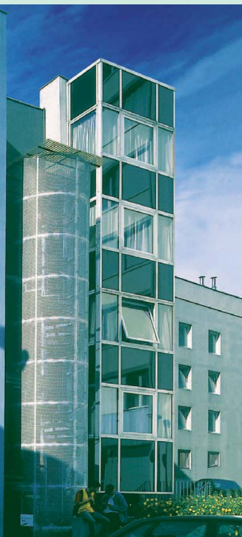
Internat du lycée Gustave-Eiffel, Bordeaux, Jacques Hondelatte architecte © Philippe Ruault
