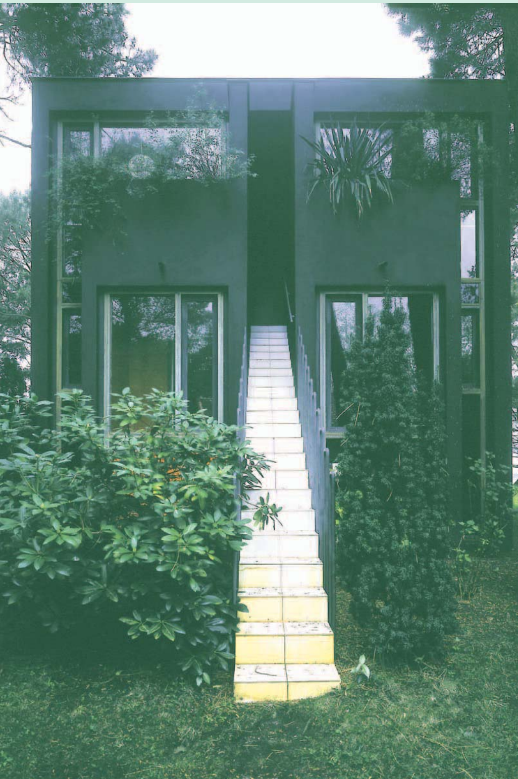
Maison Darbon-Barrau, Arès, Jacques Hondelatte architecte © Philippe Ruault
