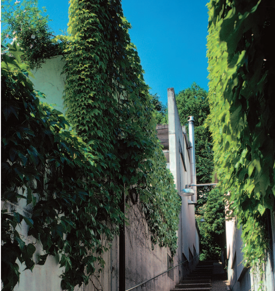
Logements de Halen, Herrenschwanden (1955-1961), 78 logements et 5 ateliers, Atelier 5 architecte © Atelier 5
