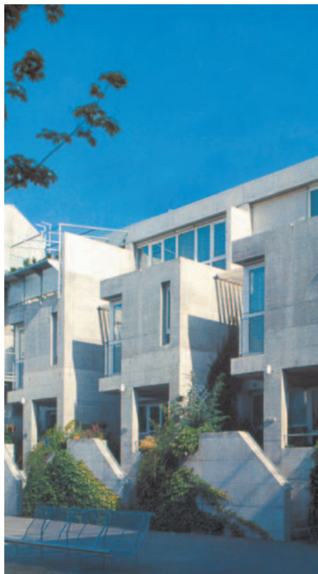
Quartier de Ried W2, Niederwangen (1983-1990), 93 appartements et studios, 11 ateliers, Atelier 5 architecte © Atelier 5
