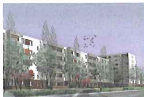
Réhabilitation 223 logements à Gien (45) VIRTUEL Architecture (75)
