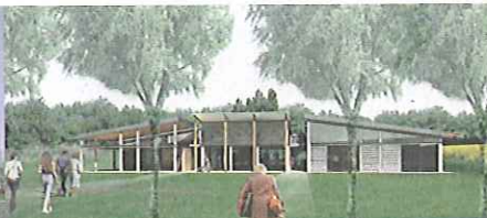
Construction maison des solidarités à Baugy (18) - PENNERON (37)
