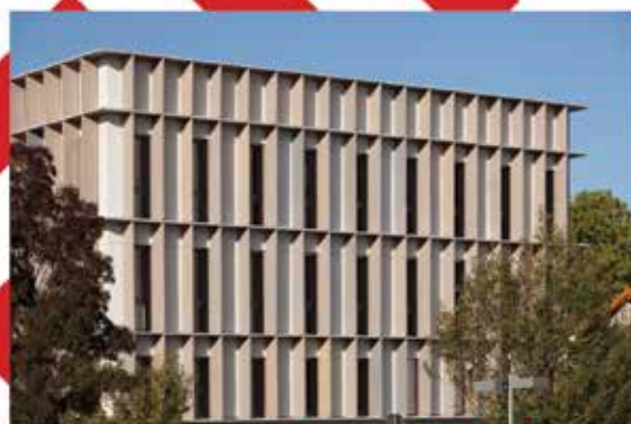
Hôpital de jour - 63 Clermont Ferrand - Tectoniques Architectes - © Jérôme Ricolleau
