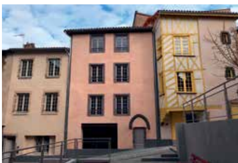
Réhabilitation de sept logements - Thiers (63) Maîtrise d'œuvre : ACA architecte et associés + Dominique Gendre Lauréat catégorie « Habitat groupé et collectif : rénovation »
