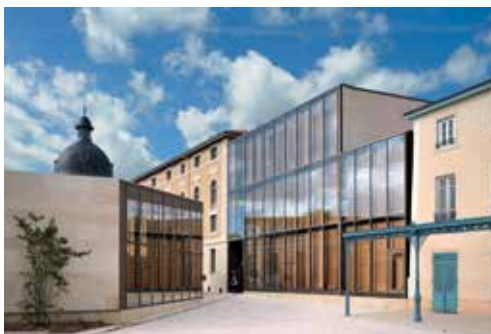
La Passerelle - Trévoux (01) Maîtrise d'œuvre : Vurpas architectes Lauréat catégorie « Construction publique et lieu de travail : rénovation »
