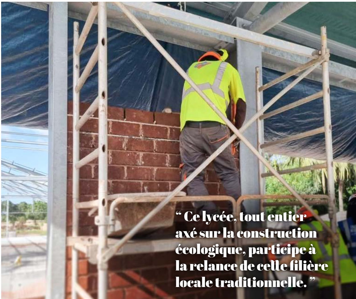
Edification d'un mur du Lycée des métiers du bâtiment de Longoni, contribuant à la relance de la filière brique en terre crue comprimées (BTC) à Mayotte.
