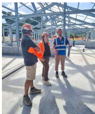
Christine Leconte, Présidente du Conseil national de l'Ordre des architectes, en visite sur le chantier du Lycée des métiers du bâtiment à Longoni à Mayotte, conçu par les agences Encore Heureux Architectes et Co-architectes.
