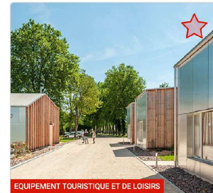
Transformation de la gare en gîtes et espaces d'expositions Leuglay (21) Architectures Adelfo Scaranello
