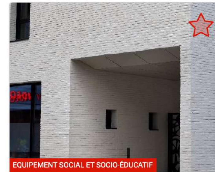
Centre d'accueil du "PRADO" Nevers (58) ARSENAULT Eric - architecte
