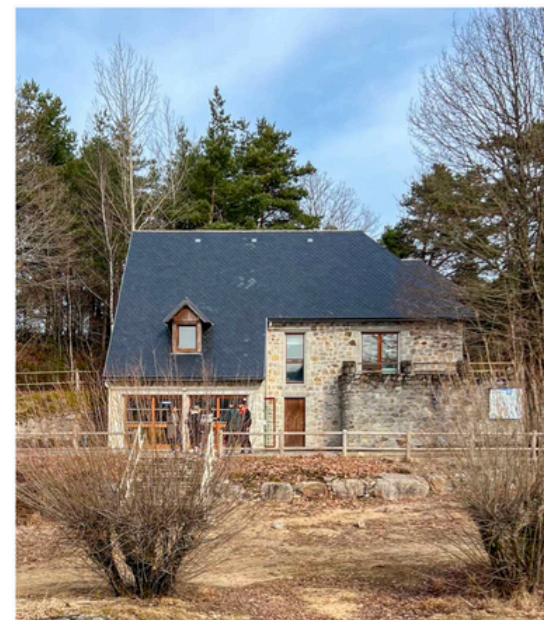
B. Photographie de la façade Sud de la base nautique
