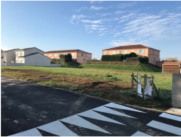
Photographie d'un chantier
