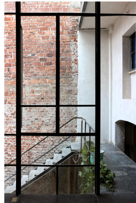
PROPORTION D'UN MODULE - Redécoupage des vitrages pour protection des parties basses.
